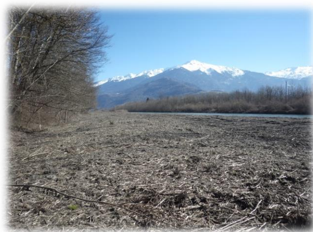
Travaux d'essartage (EDF) sur les bancs de l'Isère entre Pont-Royal et le pont de Grésy – O. Montavon, Écosphère
