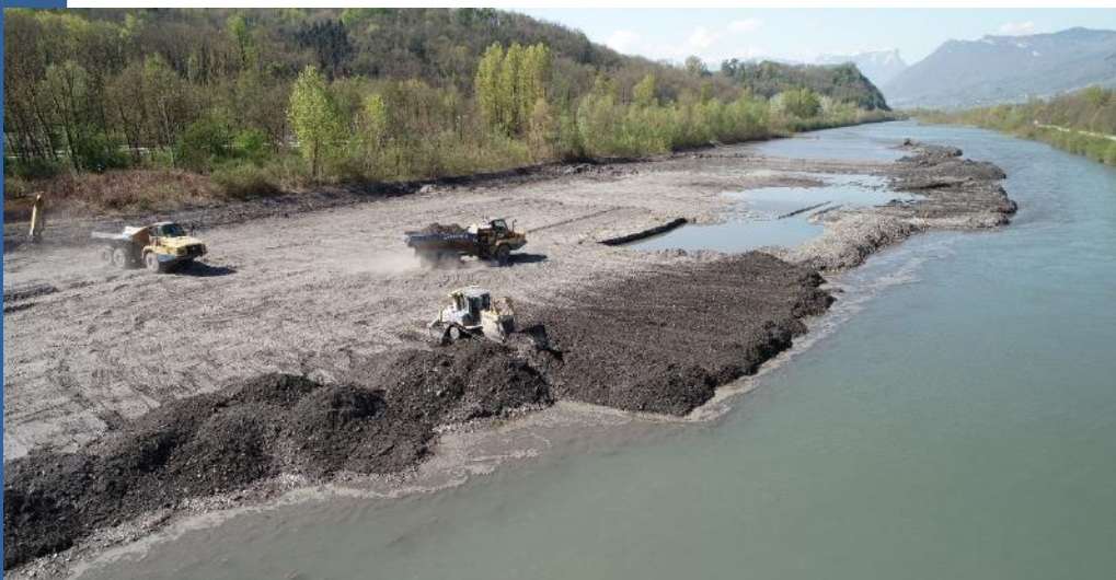
Travaux mécanique de pérennisation – Avril 2021
