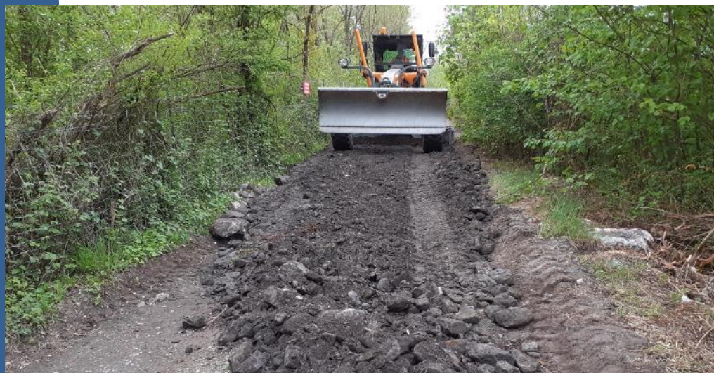
Réfection du chemin de digue – Avril 2021
