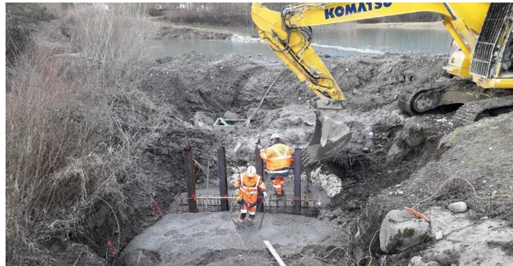
Réfection du piège à embâcle sur le ruisseau de Verrens – Février 2021
