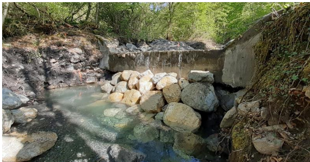
Reprise en sous œuvre du seuil du Moratier – Torrent du Fournieux – Avril 2021
