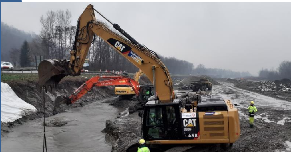
Chantier sécurisation digue Montailleir – 1 er Décembre 2021
