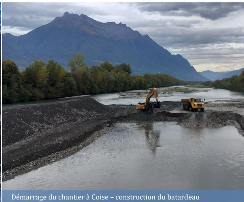
Démarrage du chantier à Coise – construction du batardeau
